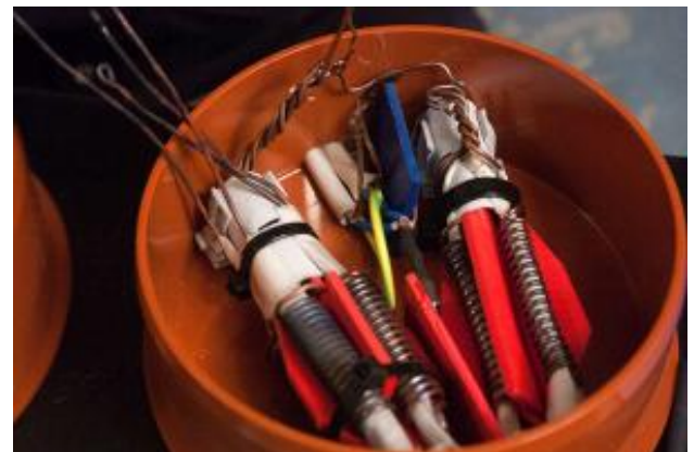
Rysunek 29. Dwa zestawy kondensatorów, w obudowie po rurze PVC (ź. [7])
